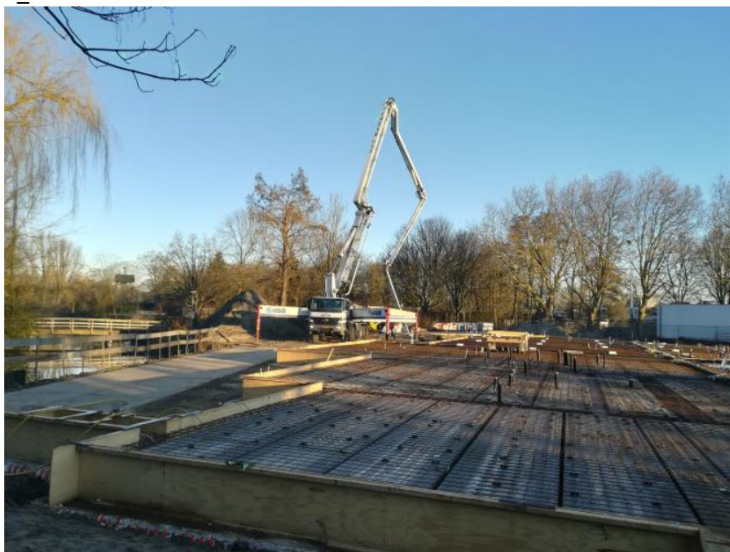
Foto: Dorps huis in aanbouw
